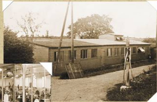
Здание первого производства
